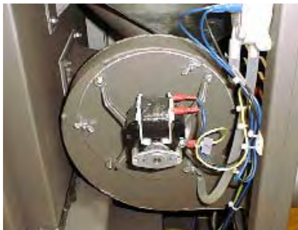
Abb. 20: Abgasgebläse und Ventilatorgehäuse
