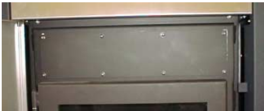
Abb. 14: Reinigungsöffnung Wasserwärmetauscher
