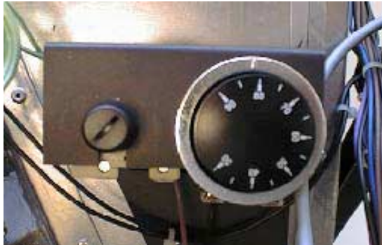
Abb. 18: Sicherheitstemperaturbegrenzer und Kesselthermostat
