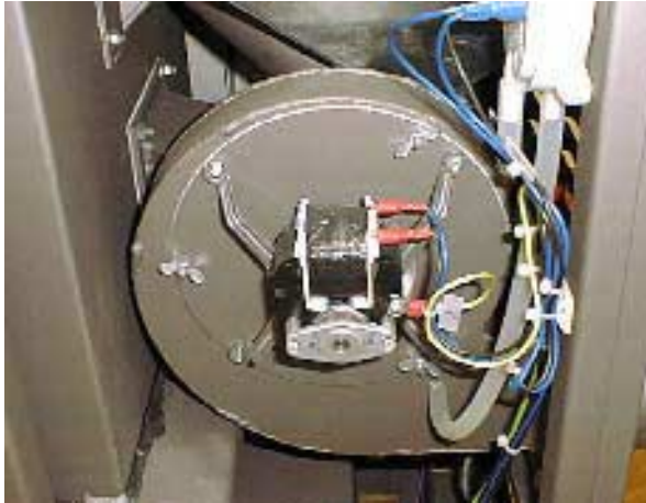
Abb. 18: Abgasgebläse und Ventilatorgehäuse
